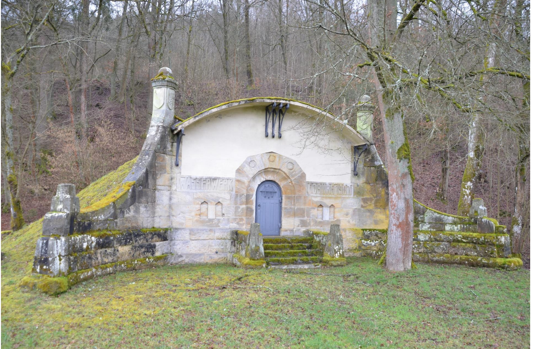
Wasserwerk in Mittelberg, Lkrs. Cbg., 1907
